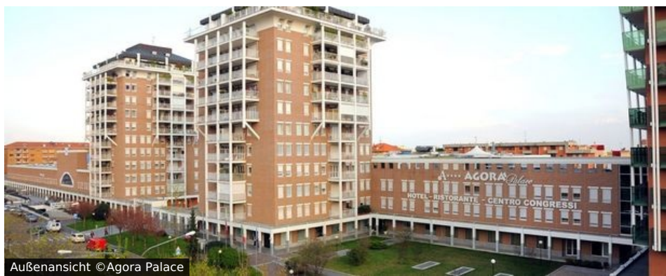
Außenansicht ©Agora Palace
