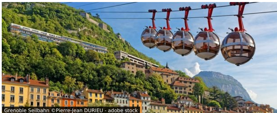
Grenoble Seilbahn ©Pierre-Jean DURIEU - adobe stock
