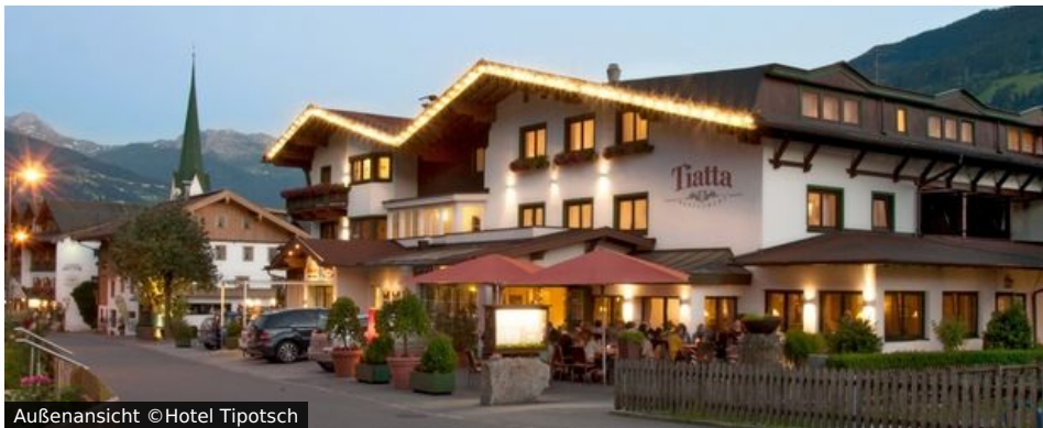
Außenansicht ©Hotel Tipotsch
