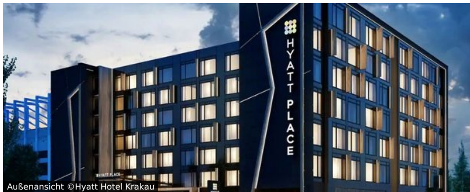
Außenansicht ©Hyatt Hotel Krakau
