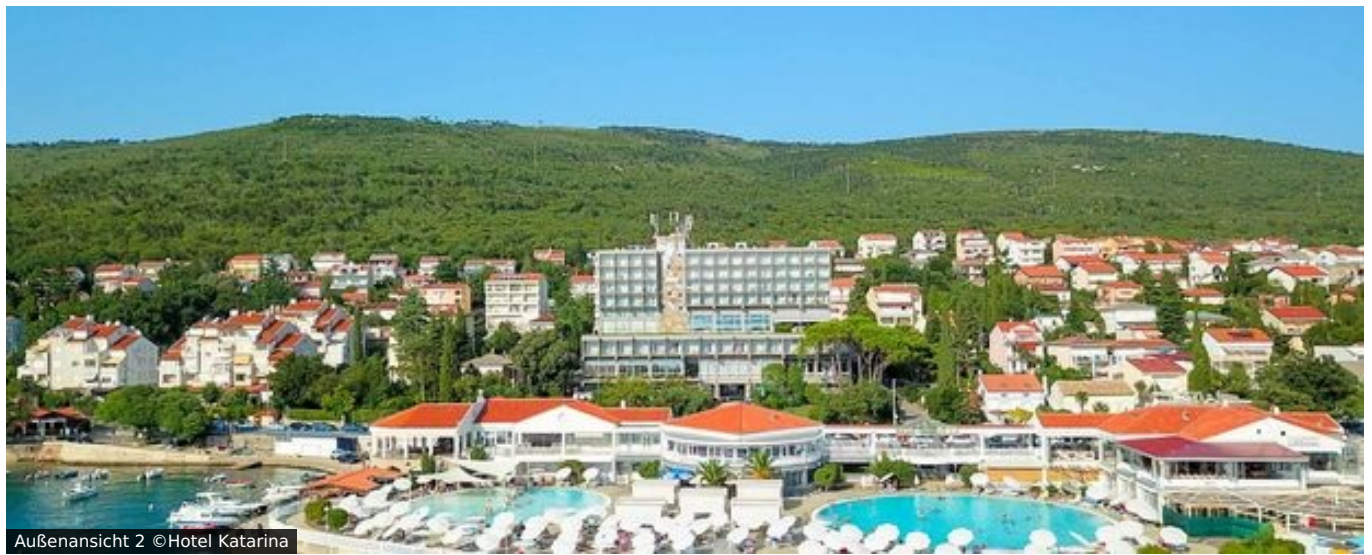
Außenansicht 2 ©Hotel Katarina
