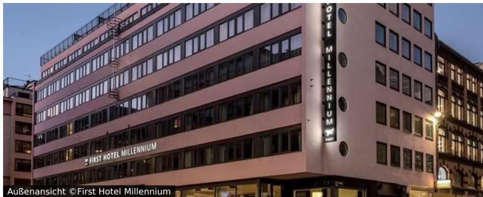
Außenansicht ©First Hotel Millennium
