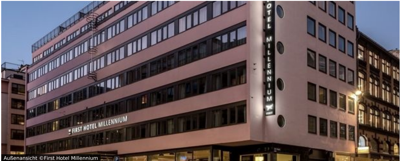
Außenansicht ©First Hotel Millennium
