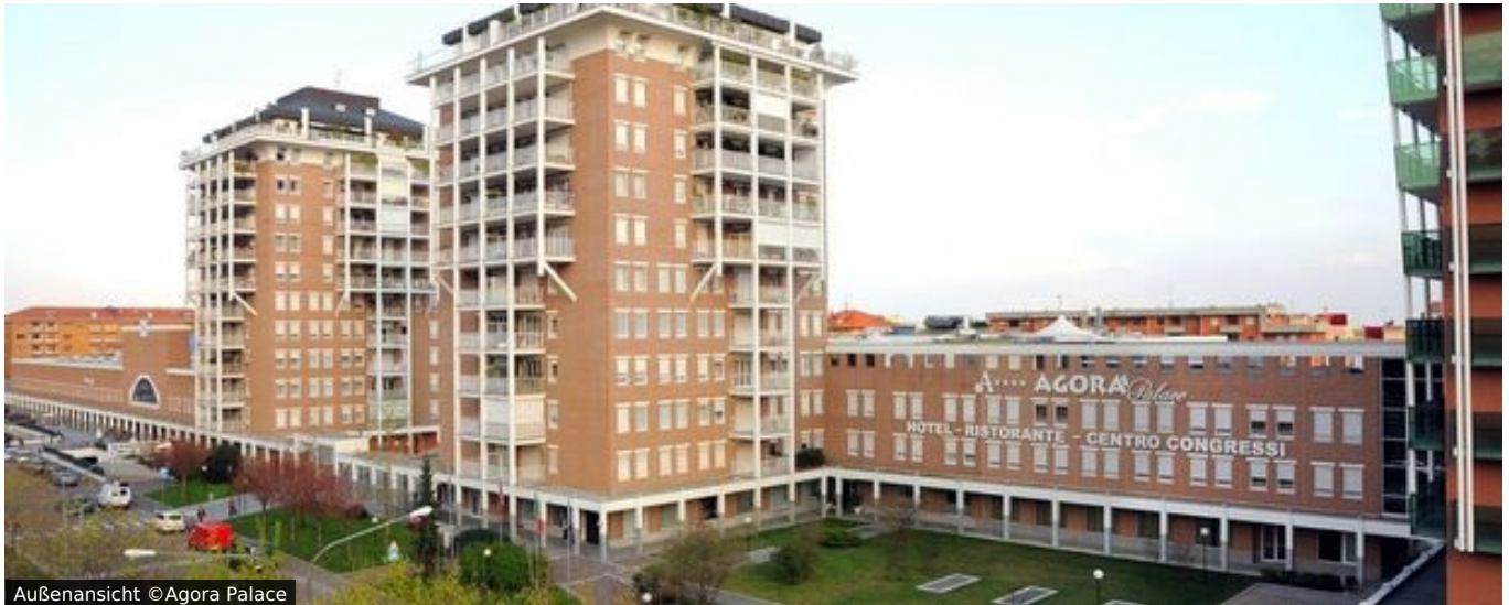
Außenansicht ©Agora Palace
