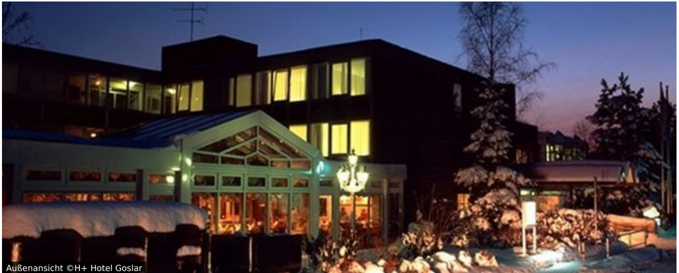
Außenansicht ©H+ Hotel Goslar
