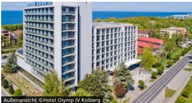
Außenansicht ©Hotel Olymp IV Kolberg
