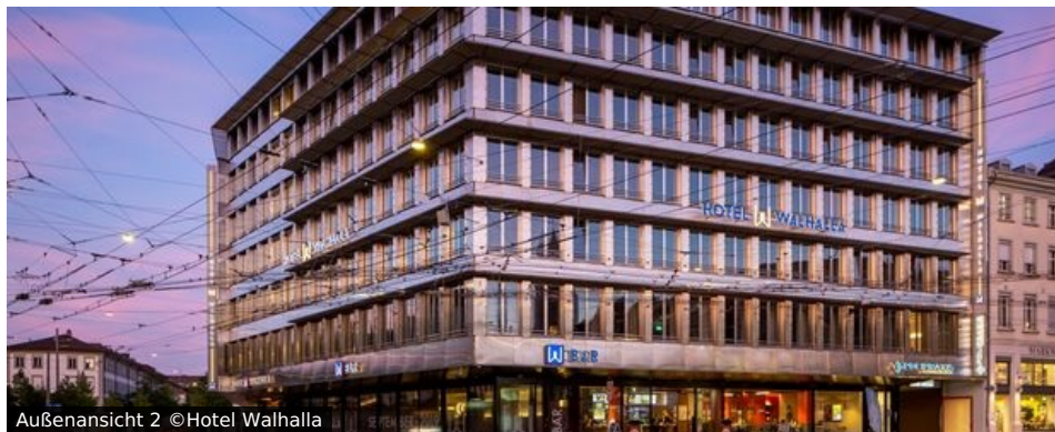
Außenansicht 2 ©Hotel Walhalla
