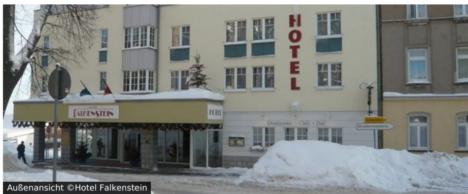
Außenansicht ©Hotel Falkenstein
