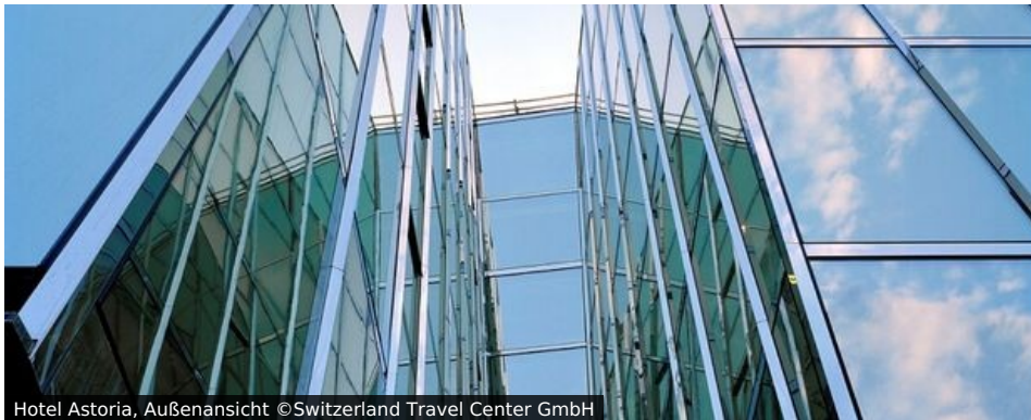
Hotel Astoria, Außenansicht ©Switzerland Travel Center GmbH
