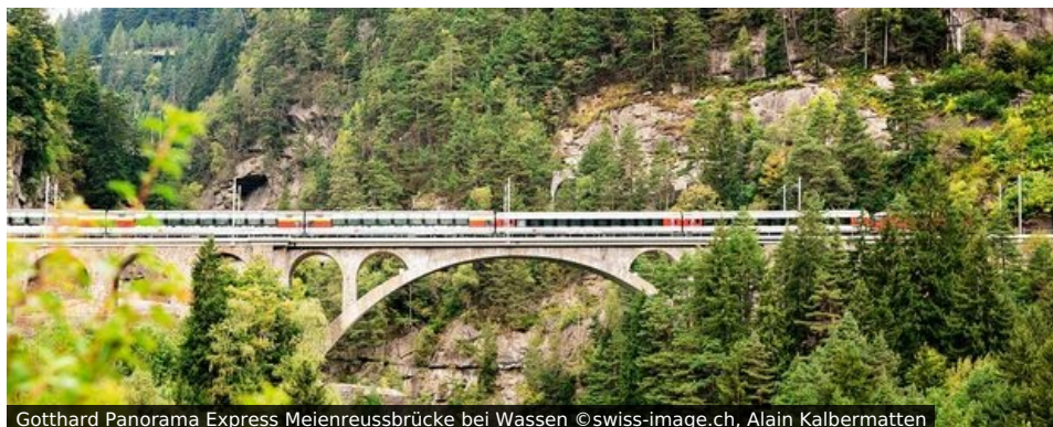
Gotthard Panorama Express Meienreussbrücke bei Wassen ©swiss-image.ch, Alain Kalbermatten
