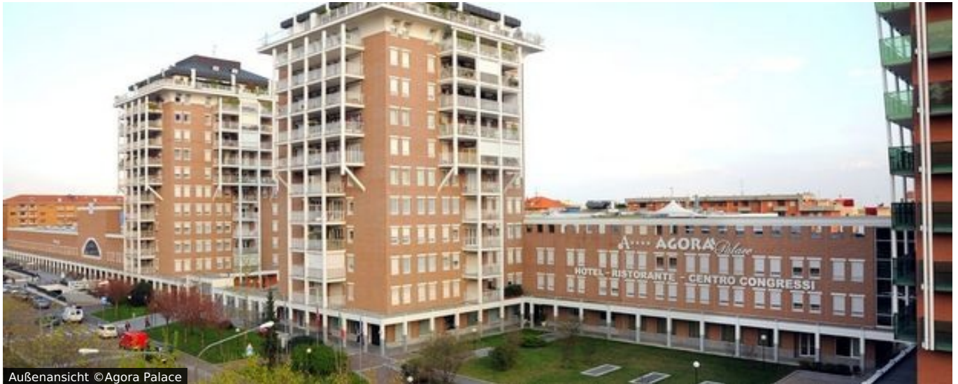
Außenansicht ©Agora Palace
