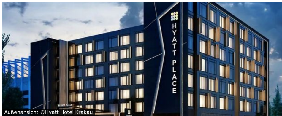
Außenansicht ©Hyatt Hotel Krakau
